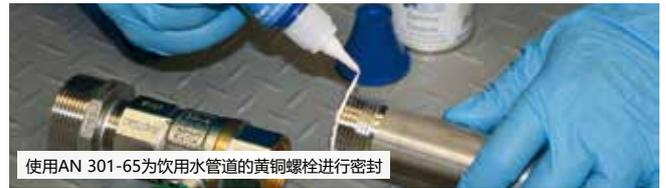
使用AN 301-65为饮用水管道的黄铜螺栓进行密封
