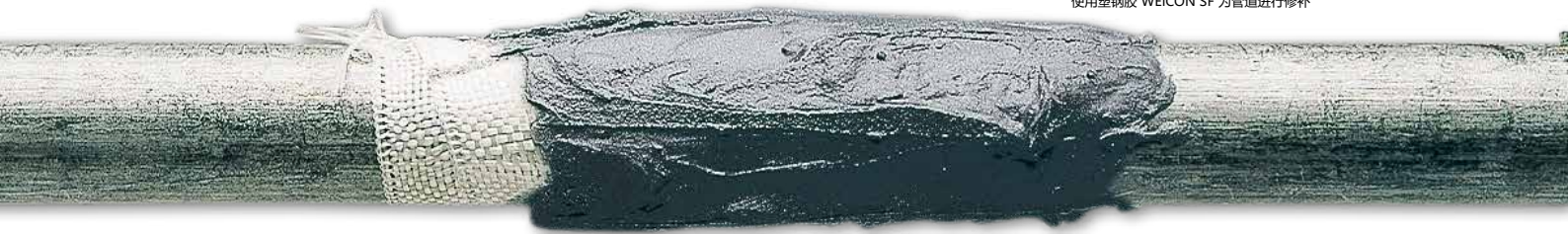
使用塑钢胶 WEICON SF 为管道进行修补
